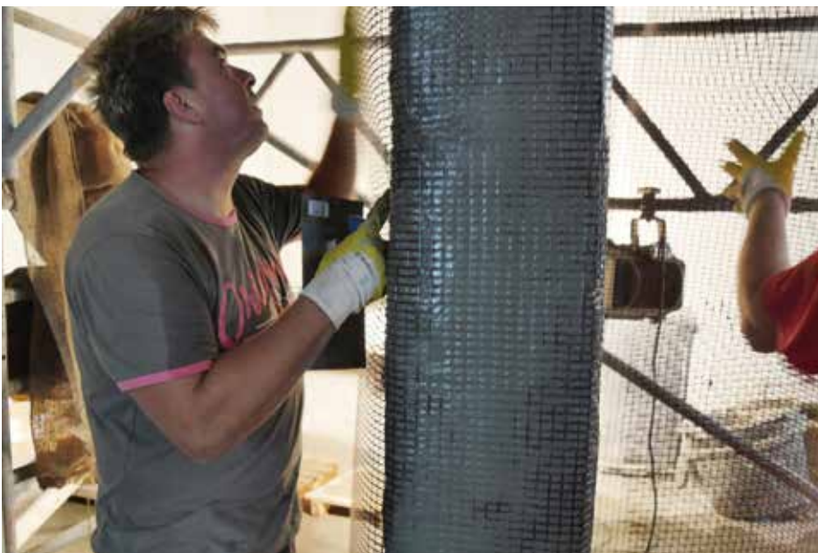
Einbau der Carbonbewehrung.
