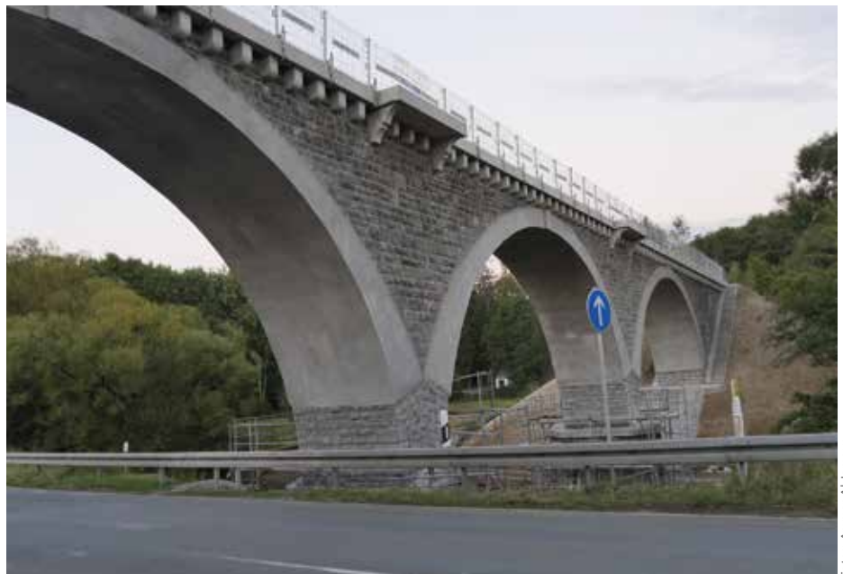
Ansicht der fertiggestellten Brücke.
