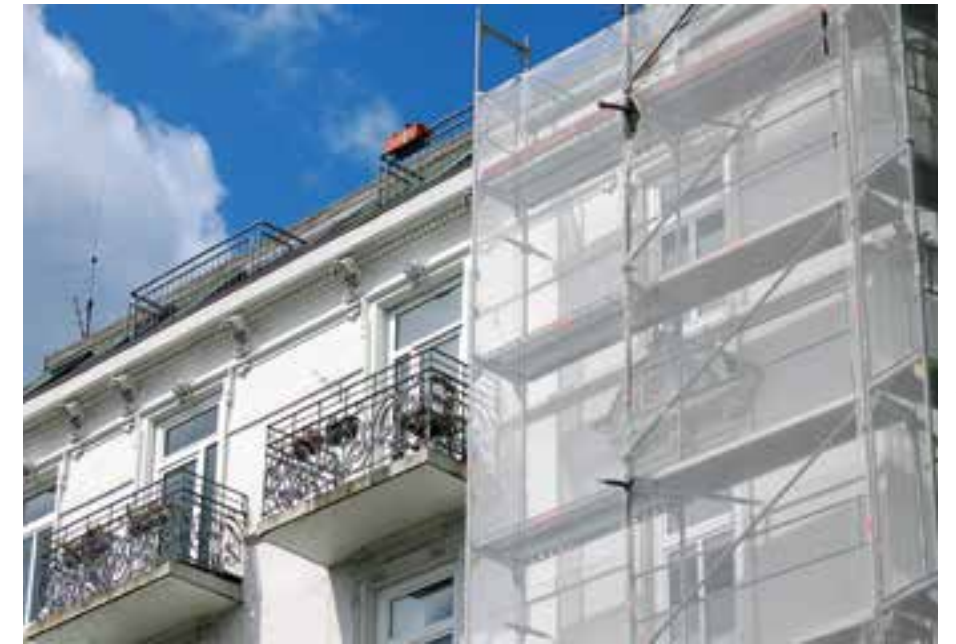
Sanierung von Bestandsimmobilien
