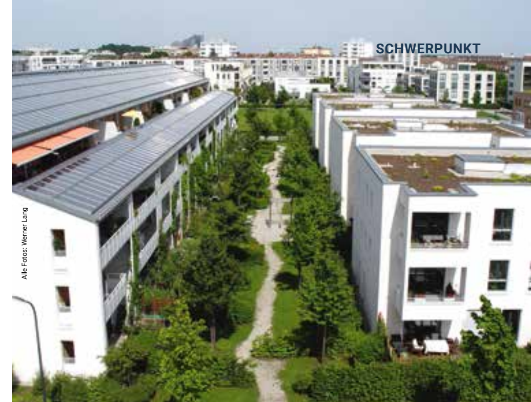
Integrierte thermische Solarkollektoren, Wohnungsbau Ackermannbogen, München
