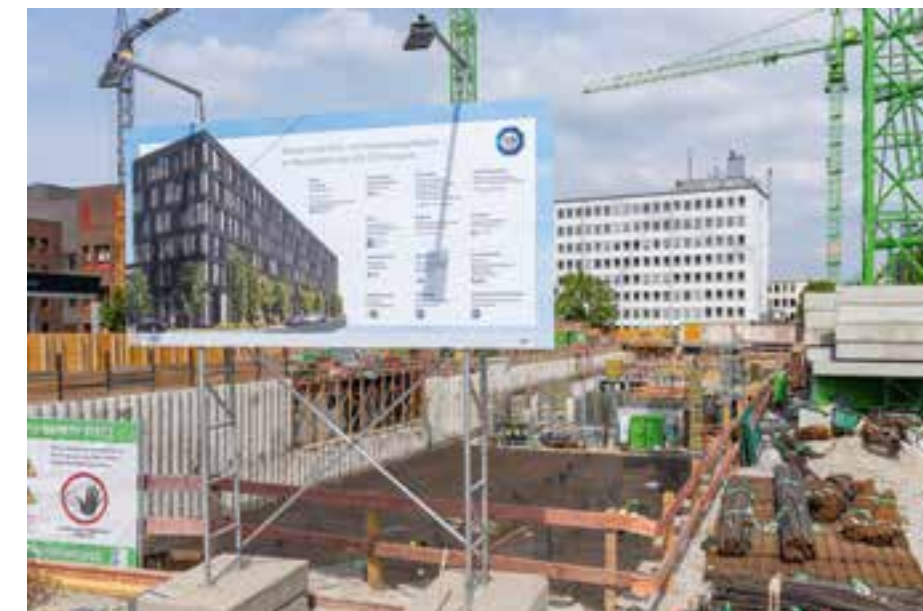
Die Baustelle des Neubaus „Algorithmus“ an der Westendstraße
