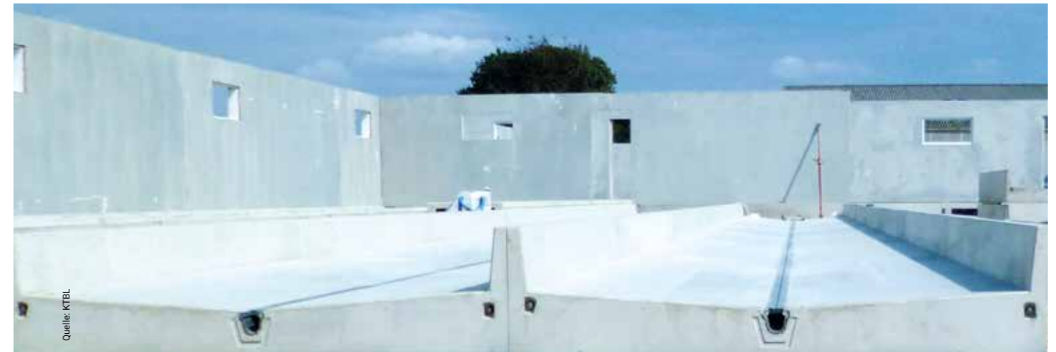
Beton-Fertigelemente für die Kot-Harntrennung und Schiebereinsatz
