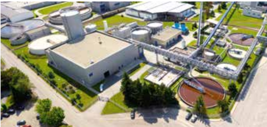
Abwasserreinigungsanlage von UPM, Plattling
