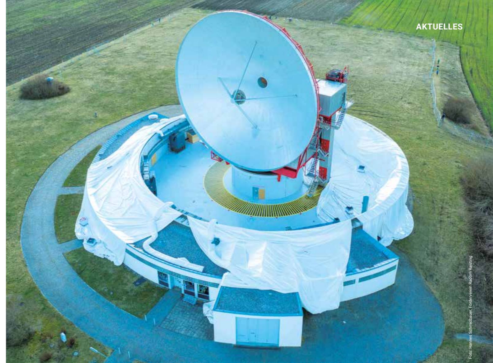
Hier ist gut zu sehen, dass die Hülle des Radom Raisting von Böen des Sturms „Bianca“ in drei Teile zerrissen wurde, Aufnahme vom 1. März 2020
