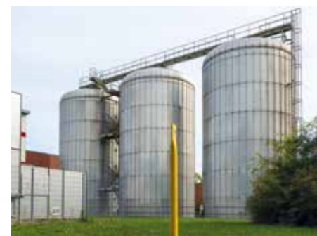
Auf dem Gelände der WKZ Nord wird das iKWKS-System umgesetzt
