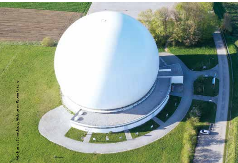
Industriedenkmal Radom Raisting: Die Antenne 1 steht geschützt unter der Traglufthülle, Aufnahme vom April 2019
