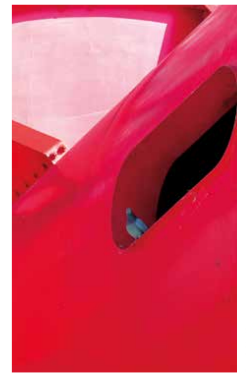
Hier ist gut zu sehen, dass die Hülle des Radom Raisting von Böen des Sturms „Bianca“ in drei Teile zerrissen wurde, Aufnahme vom 1. März 2020
