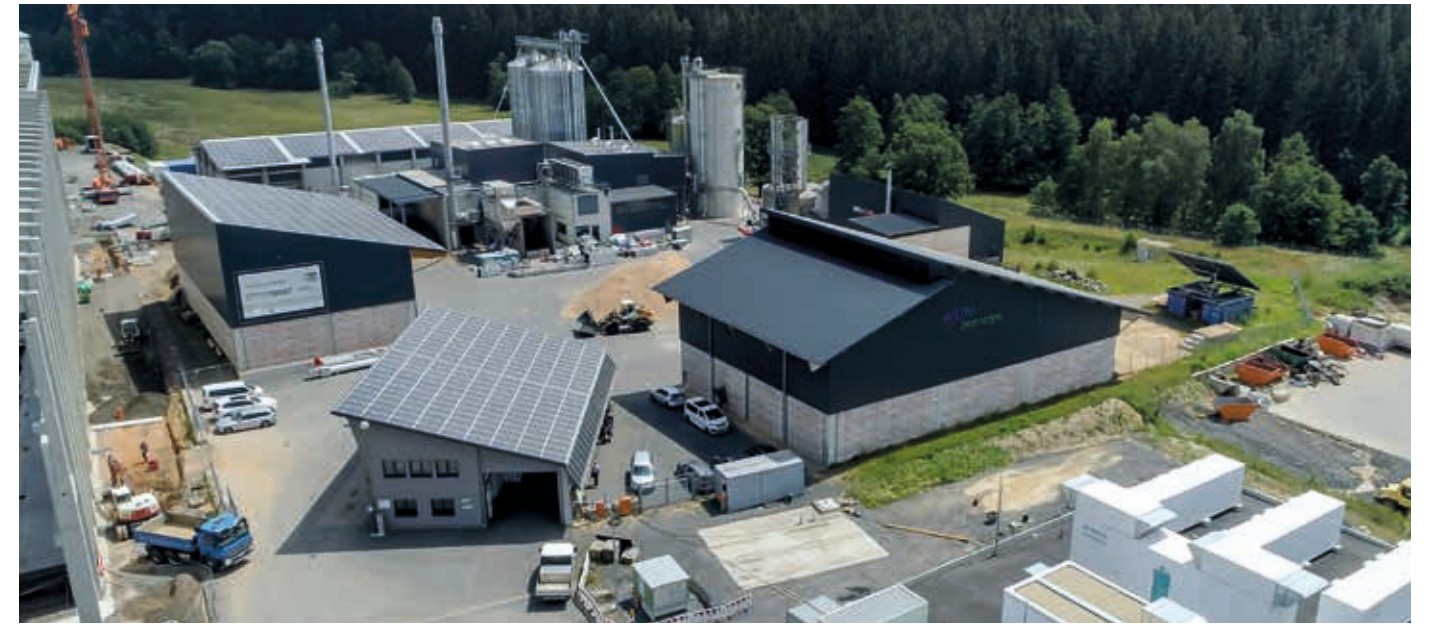
Bioenergie- und Pelletswerk im Energiepark Wunsiedel
