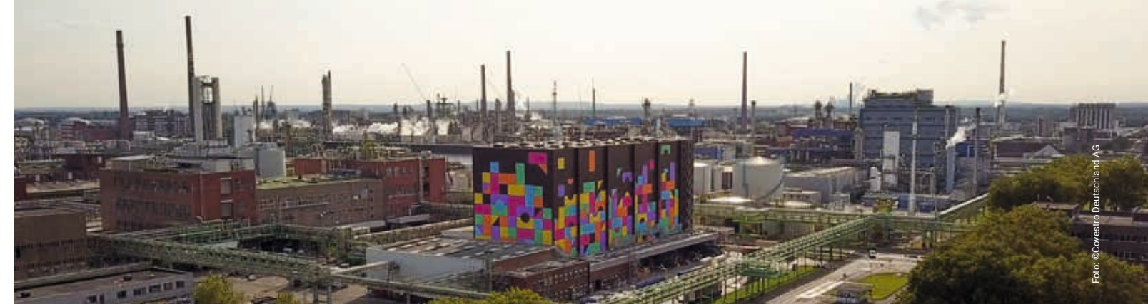
Produktionsstandort von Covestro im CHEMPARK Dormagen
