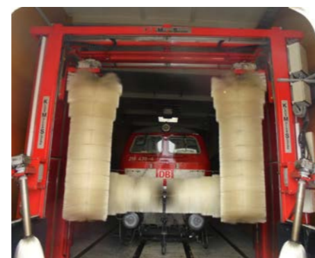
Die Lokomotivenwaschanlage in Mühldorf
