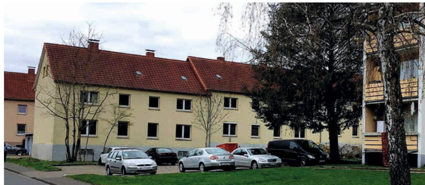
Wohnobjekte aus den 30er-Jahren vor der Sanierung
