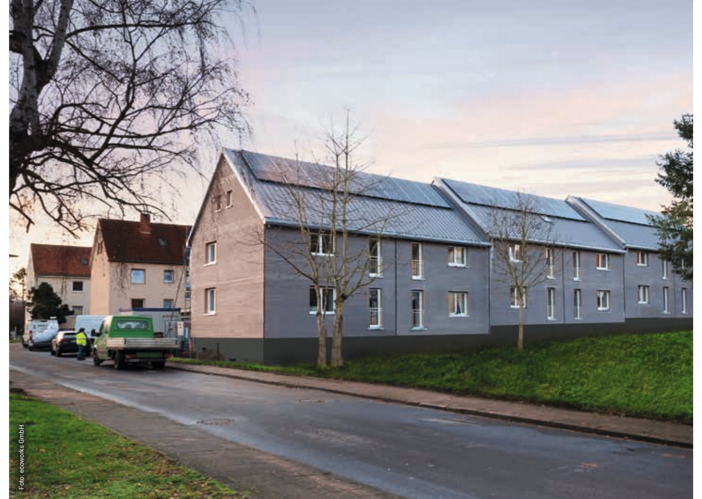
Wohnobjekte saniert (vorne) und unsaniert (hinten), Verbrauchs- und Emissionswerte siehe Kasten
