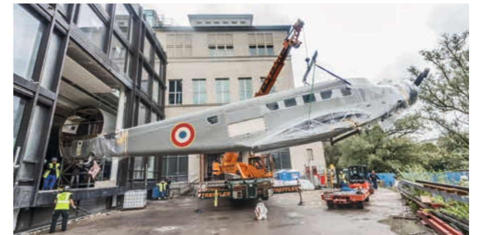
Mit einem Kran wird die „Tante Ju“ ins Ausstellungsgebäude gehoben
