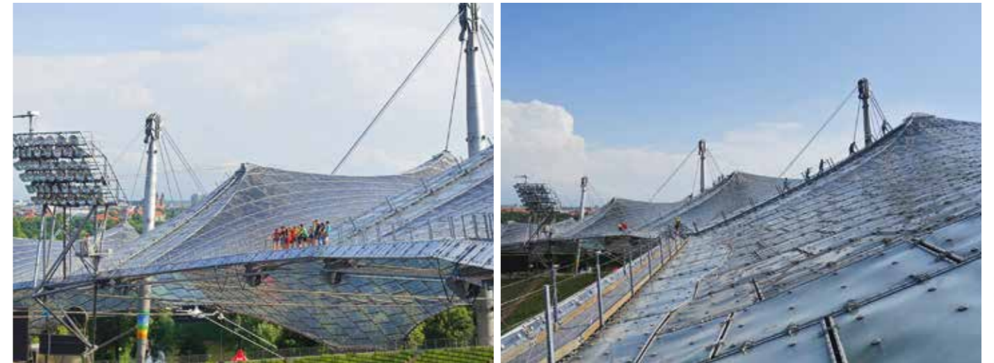
Das Dach des Olympiastadions in München, Begehung durch Studierende des „Membranworkshops“ an der TU München
