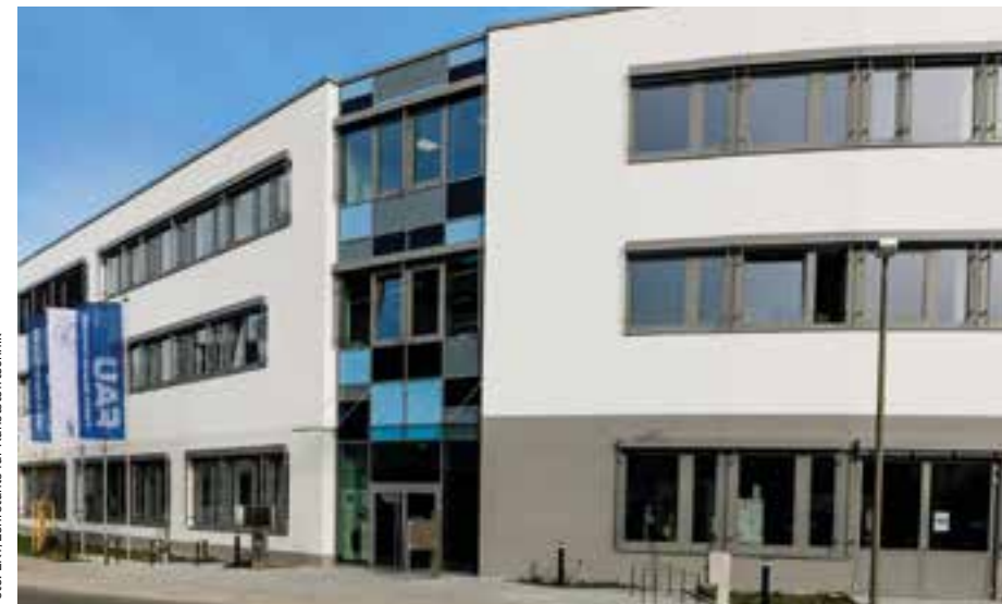
Neubau des Lehrstuhls für Kunststofftechnik der Friedrich-Alexander-Universität in Erlangen-Tennenlohe
